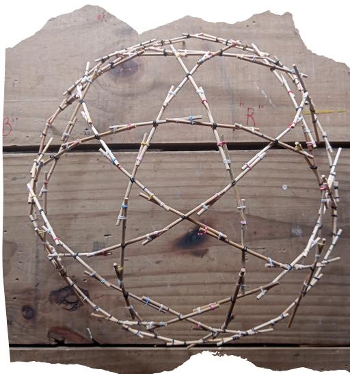
Bambu cresce rápido, é um material de graça para a estrutura de um domo. Pode ser que seja possível suspender a cobertura para uma barraca ou uma proteção contra mosquitos dentro, ou esticar um tecido elástico e utilizar uma espuma (para impermeabilizar). Ferramentas: uma faca de bolso e corda. As próximas instruções foram preparadas por R. Buckminster Fuller. "Eu" ainda não tentei: A zambú já! :)
