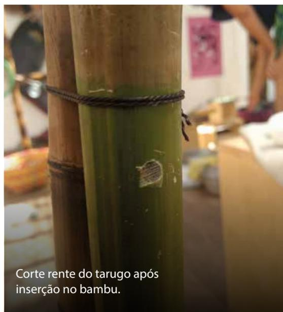
Corte rente do tarugo após inserção no bambu.
