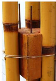
**Fig. 10 e 11 - Medidas e foto da peça em madeira maciça, utilizada para construção do pé direito.**
