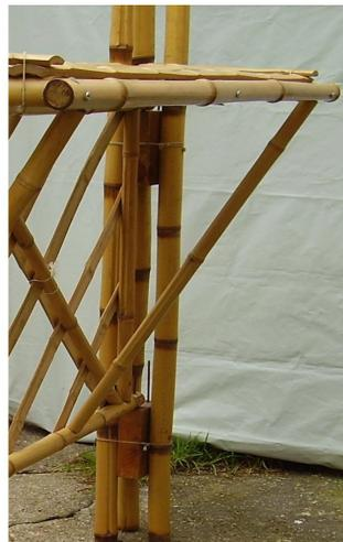
**Fig 15b e 15c – Fotos com detalhe dos parafusos nos bambus de 73 cm e a furação necessária para escoramento da bancada.**
