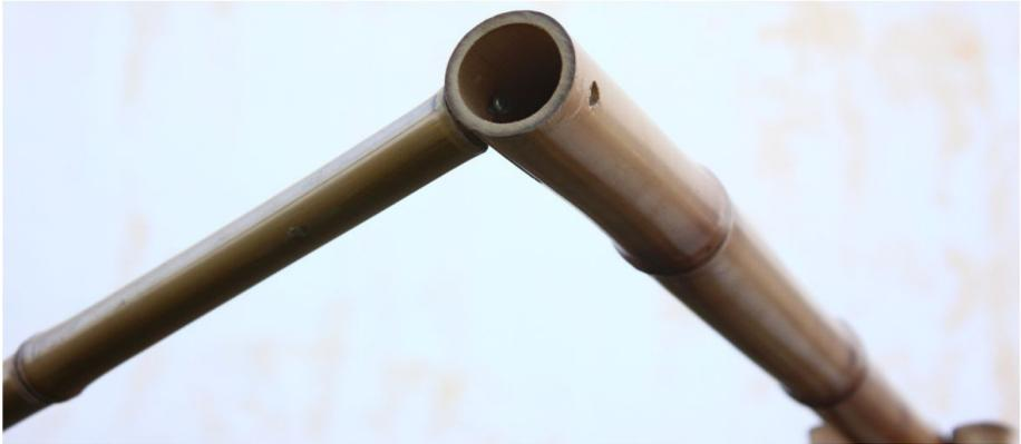
Fig. 18 –Detalhe da furação horizontal e encaixe do “beiral” nas peças de 235 cm.
